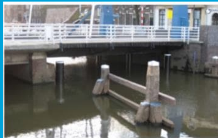
Remmingwerk met gebruikte basralocus palen
