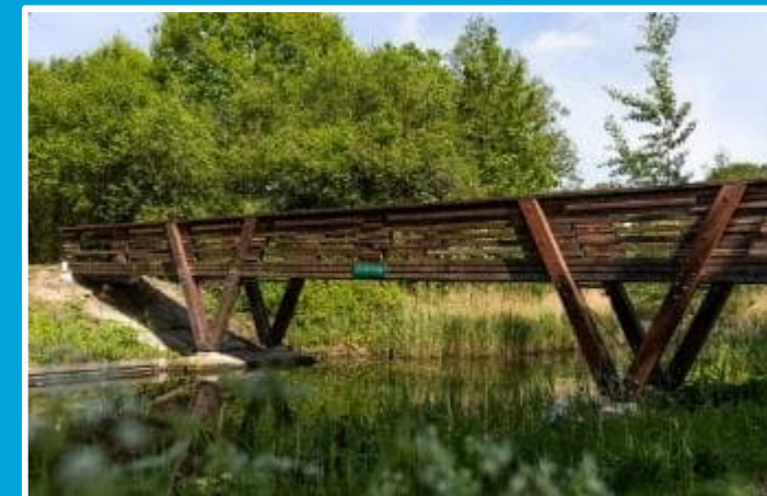
Brug uit gerecycled hout van andere bruggen
