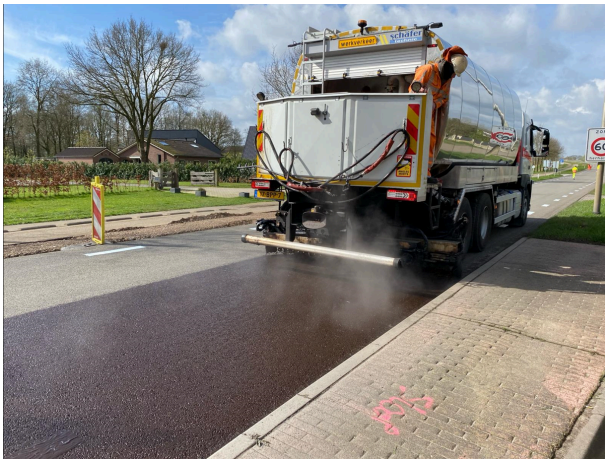
Fotobijchrift foto 1: Verjongingscrème wordt aangebracht op asfalt (N812 nabij Babberich).
