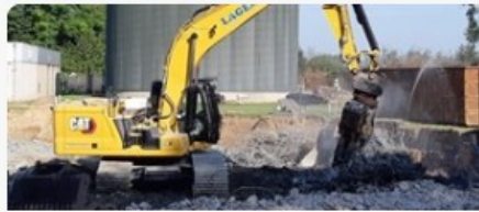
Circulaire rioolwaterzuivering Terwolde
