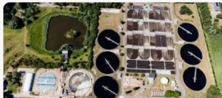
Demontage en hergebruik materialen
