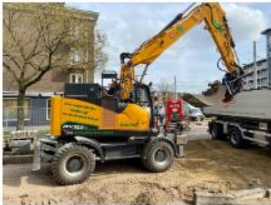
Heijmans / Aanleg fietsstraat Hugo de Grootstraat in Arnhem
