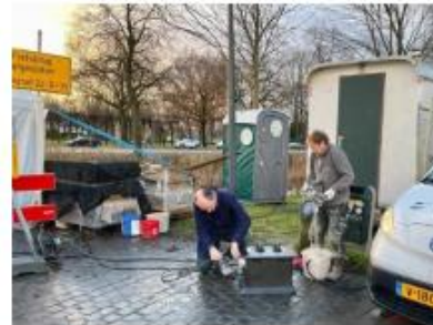
AirQon / vervangen brugdekken fietsgedeeltes Claudius Prinsenbrug
