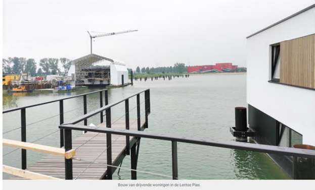
Bouw van drijvende woningen in de Lentse Plas.
