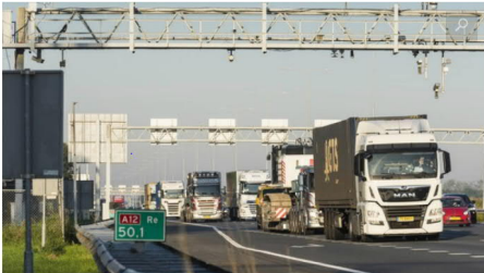
Waar nodig worden maltoeborden vervangen. RIJKSWATERSTAAT
